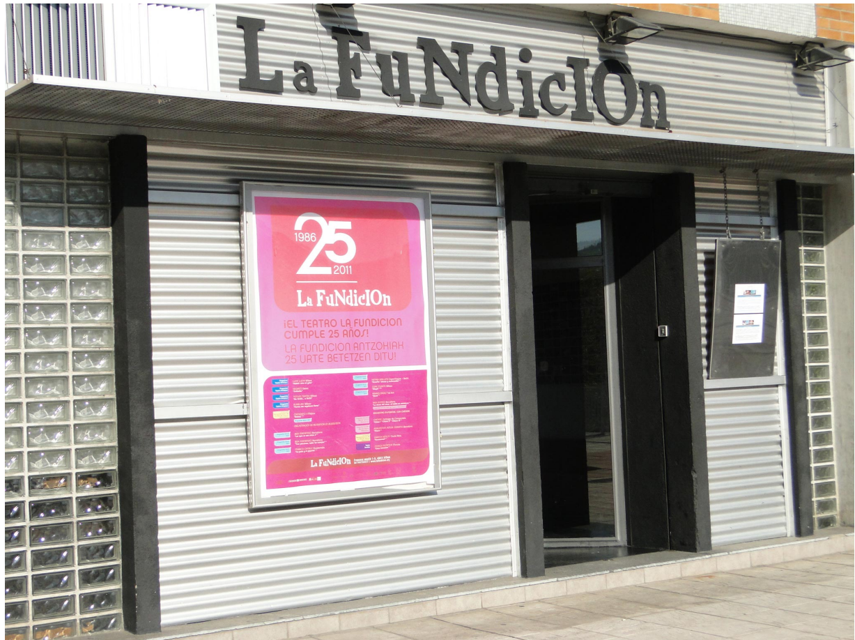
Fachada, La Fundación. Bilbao
